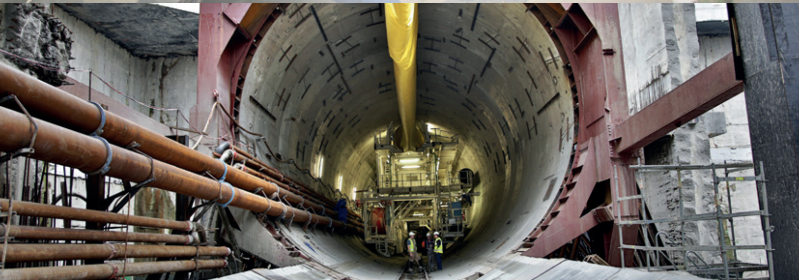
Fot. 2. Tył maszyny TBM w wydrążonej rurze tunelu Fot. z archiwum GIK
