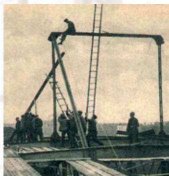
Fot. 8. Montaż konstrukcji wsporczych na moście w Grudziądzu Fot. ze zbiorów Elektrowni Wodnych w Samociążku
