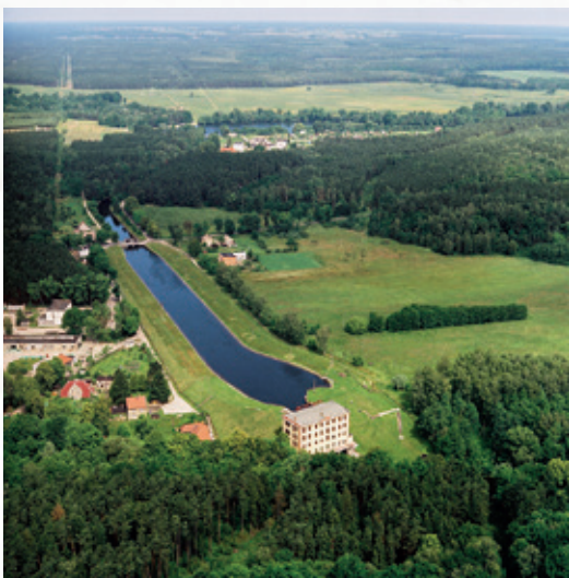
Fot. 12. Elektrownia Gródek z lotu ptaka Fot. ze zbiorów Elektrowni Wodnych w Samociążku
